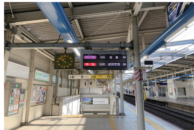
案内表示器更新工事
