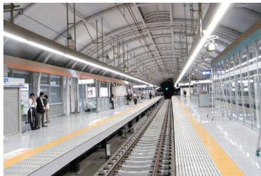
日暮里駅 総合改良事業工事
